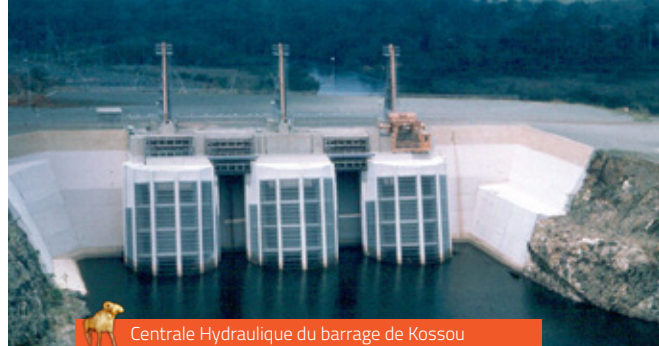
Centrale Hydraulique du barrage de Kossou
